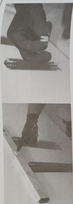
۶. مصباح رادياتور روی بست مربوطه و محکم کردن آن به شیر و زانو فعلی.
