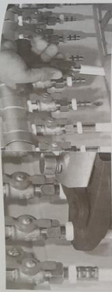
هیمنه کلکتور برگشت را بالاتر کلکتور رفت قرار دهید. این امر باعث می شود هوای موجود در آب با لولبت بهتری از سیستم خارج شود.
