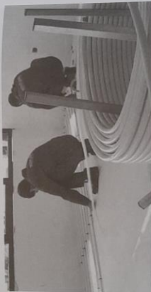
بست لوله ها عایق پشت هیمنه شده توسط هیمنس طراح تعدادی پاره خط (به عنوان خطوط رافصا) روی عایق رسم نمایند.
