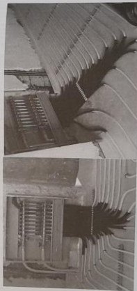
هیمنه کلکتور برگشت را بالاتر کلکتور رفت قرار دهید. این امر باعث می شود هوای موجود در آب با لولبت بهتری از سیستم خارج شود.
