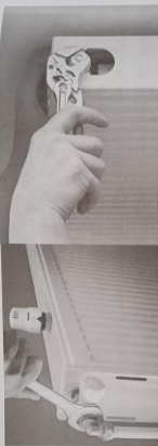
۶. مصباح رادياتور روی بست مربوطه و محکم کردن آن به شیر و زانو فعلی.
