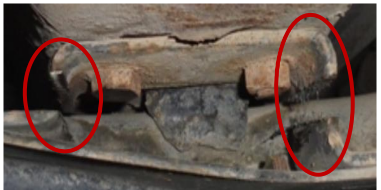
برش پایه های نمایش داده شده توسط دستگاه فرز
