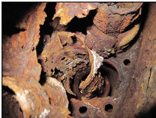
شكل شماره (۱۳) پوسیدگی قطعات داخلی انباره
