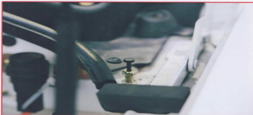
شکل نصب شده شاسی فلزی
