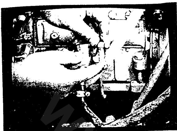
۱۰) پمپ سه کوش از نوع پیستونی بوده و این فیلتر کوچک موجب جلوگیری از خوردگی سریع پیستون میگردد، همچنین باعث شده که اجسام خارجی وارد شیر یکطرفه نشوند.
