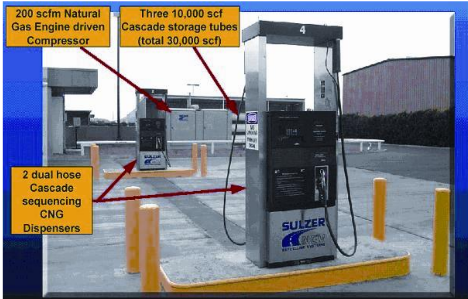
شکل ۲۲: نمایی از یک ایستگاه سوخت‌رسانی CNG
