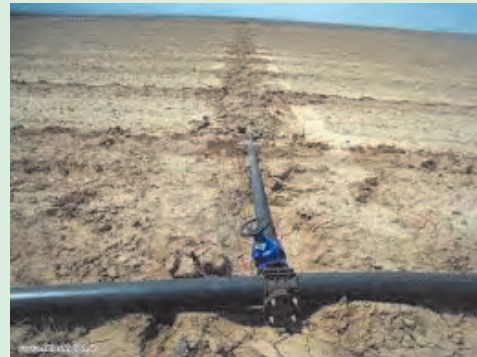
شکل ۴۶-۵. شیر فلکه لوله جانبی
