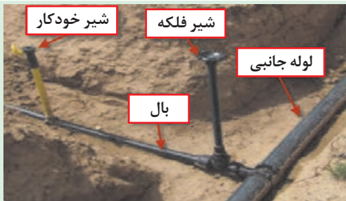
شکل ۱۳-۵. محل شیر فلکه روی بال
