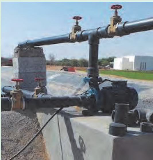
شکل ۱۲-۵. شیر فلکه لوله رانش
