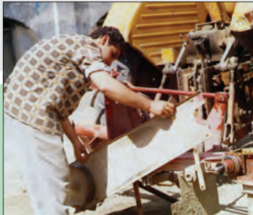
شکل ۱۵- پیاده کردن حفاظ
