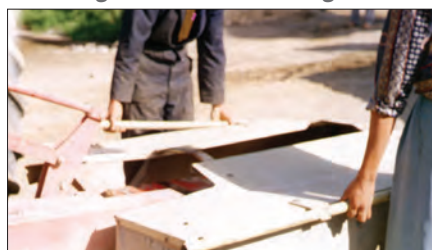
شکل ۶- پیاده کردن حفاظ
